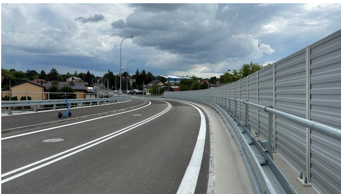
Zdjęcia. Budowa wiaduktu łączącego ul. Grunwaldzką z ulicą Warszawską
