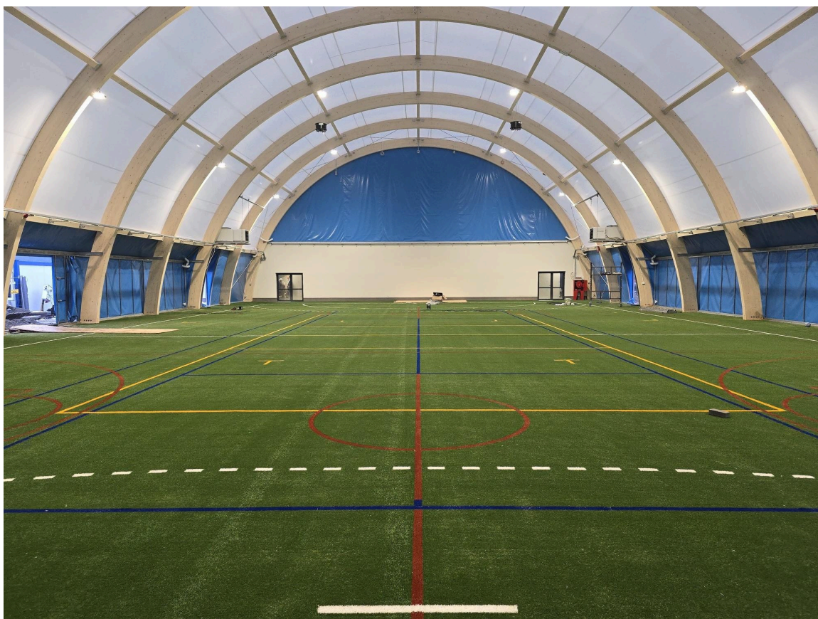
Zdjęcie. Budowa hali sportowej przy Szkole Podstawowej nr 1
