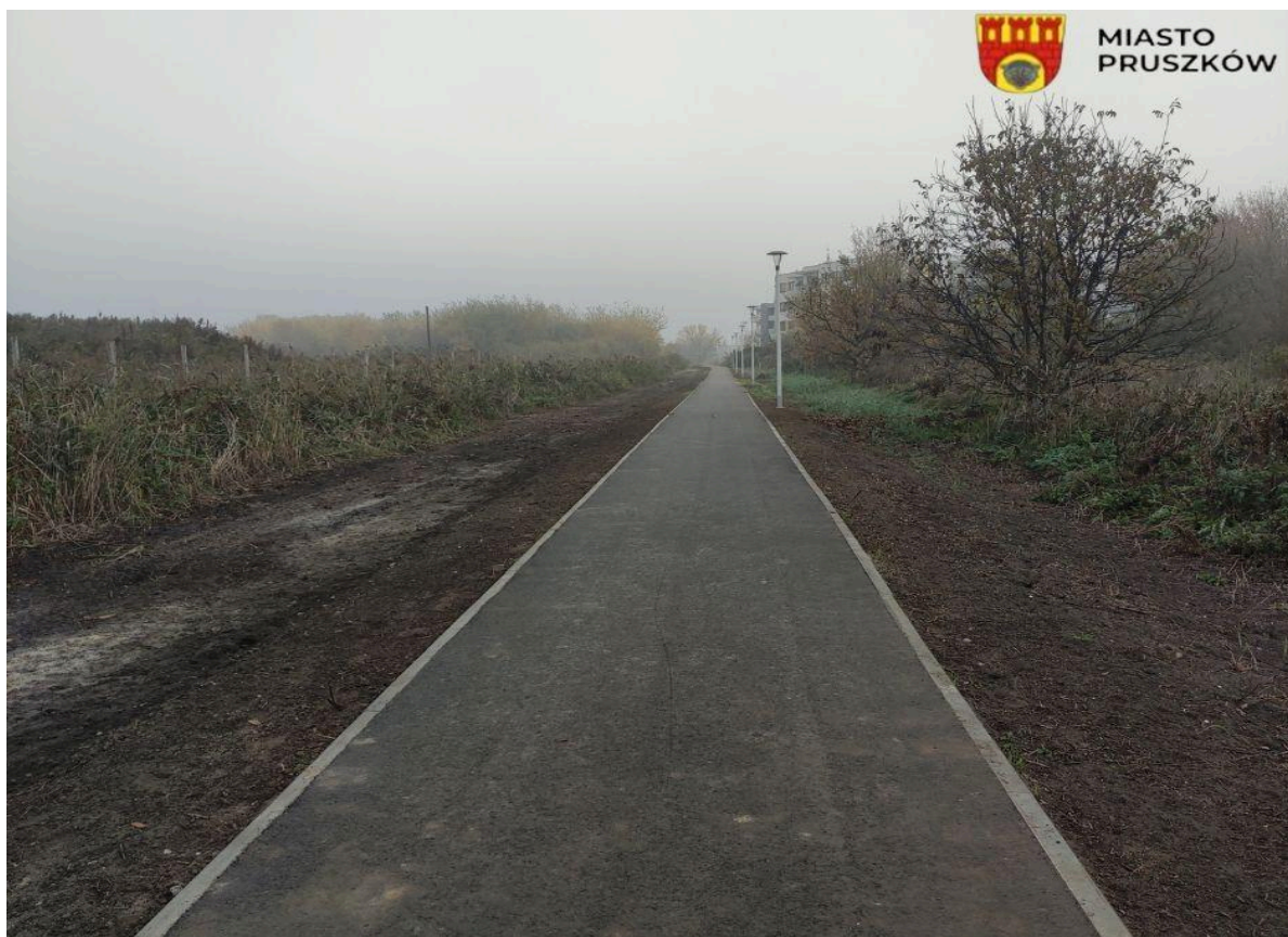
Zdjęcie. Budowa ścieżki rowerowej od mostku przy ulicy Rusałki do ulicy Długosza
