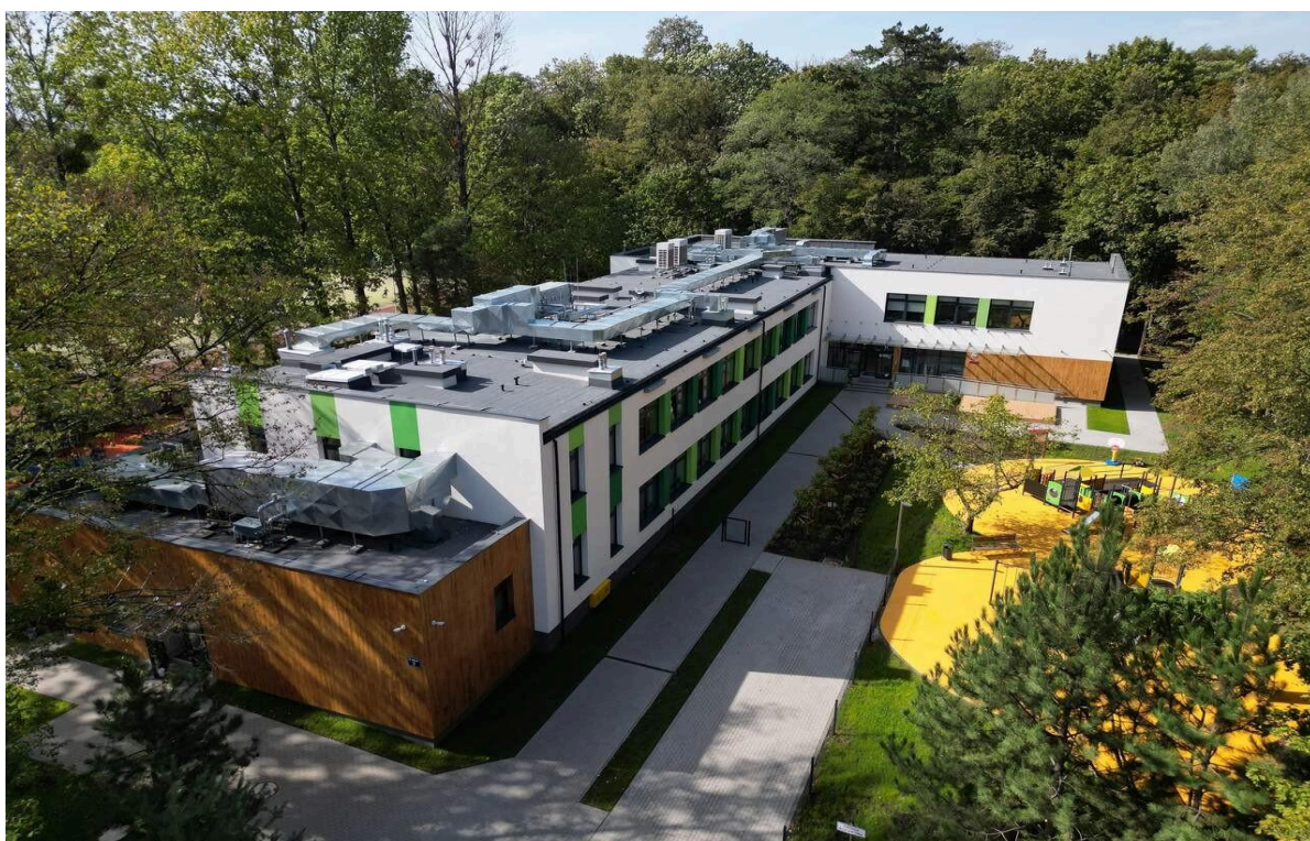
Zdjęcia. Termomodernizacja i przebudowa budynku Przedszkola Miejskiego nr 11 przy ulicy Hubala
