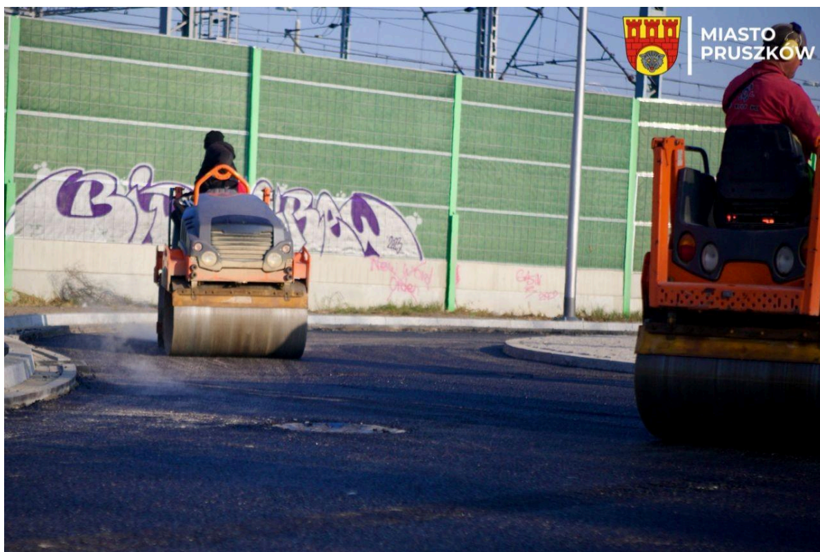
Zdjęcie. Budowa ulicy Przytorowej
